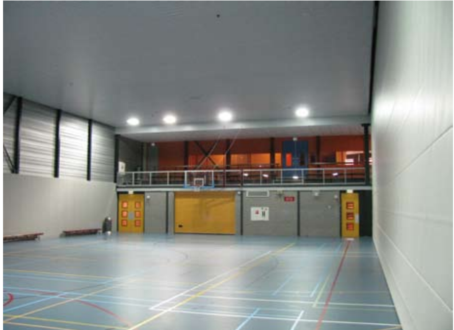
■ Onvoldoende geluidabsorberend materiaal in de onderste zone zorgt voor een lange nagalmtijd.
