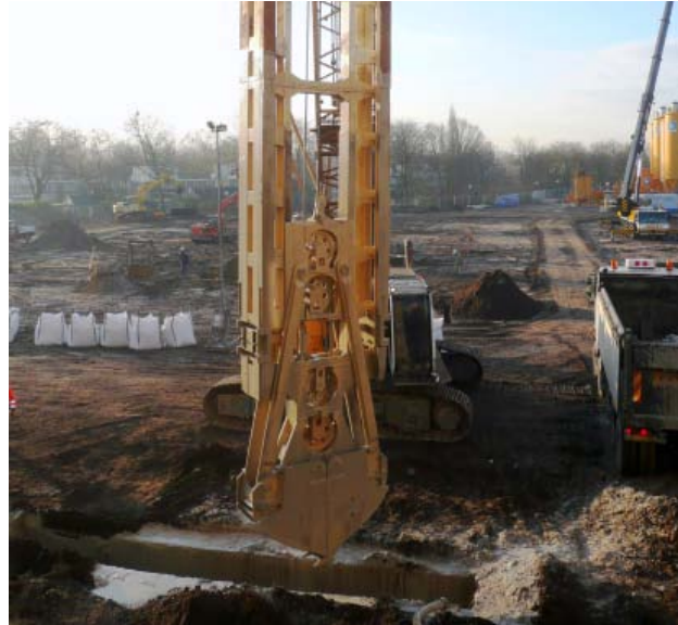
Rechts: Ook het maken van diepwanden kan risico's naar de omgeving geven.
